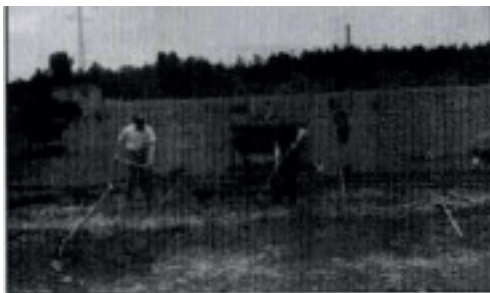
Umbau des Platzes
